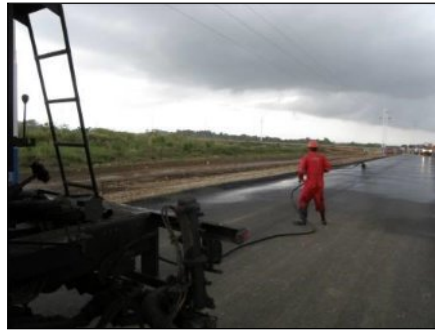
Figura 10. Aplicación del riego de adherencia
