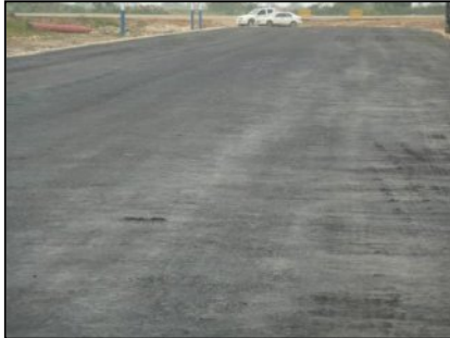
Figura 5. Superficie imprimada con emulsión asfáltica después de 24 h
