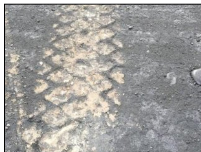
Figura 9. Huellas por paso vehicular
