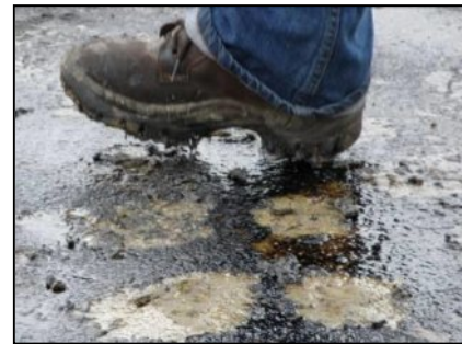
Figura 8. Desprendimiento del riego al caminar sobre la superficie
